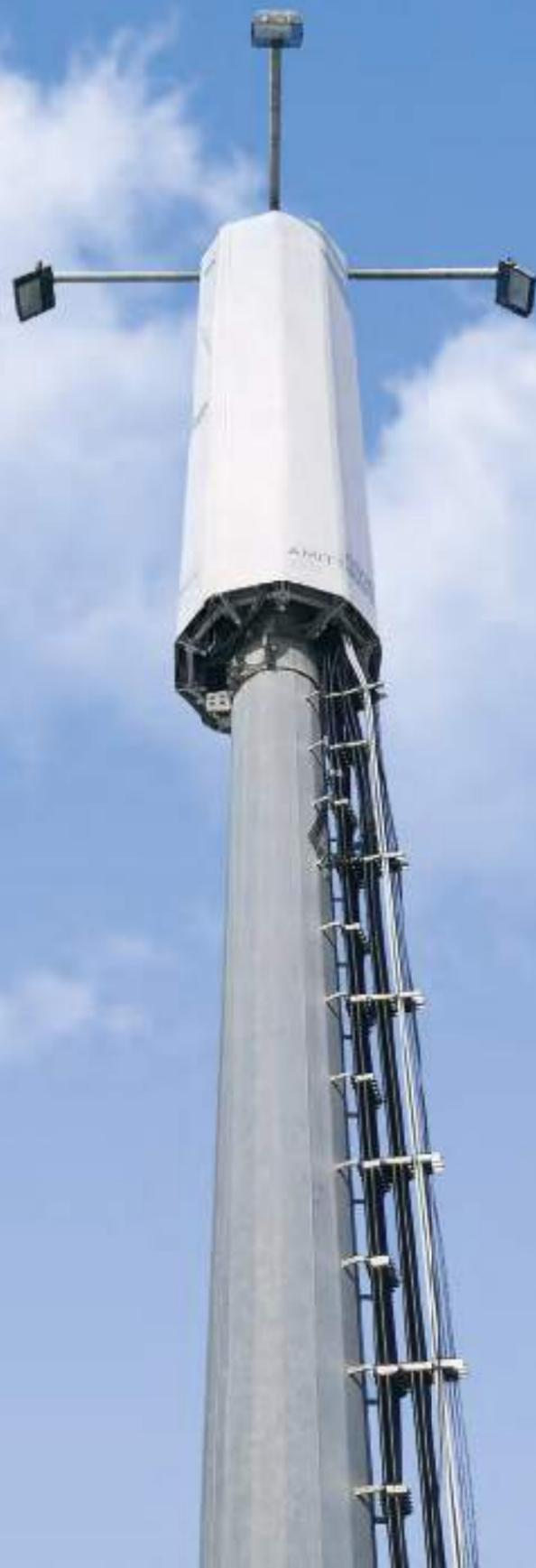
Dal 2014 TLB si è affermata nel settore delle telecomunicazioni anche grazie alla produzione e installazione di mascheramenti di antenne e apparati con materiali che garantiscono la massima sicurezza e la piena integrazione con l'ambiente circostante.
